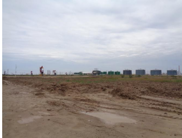
泥浆池固化覆土后照片
