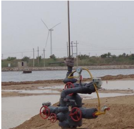
图 3-4 套管气回收装置
